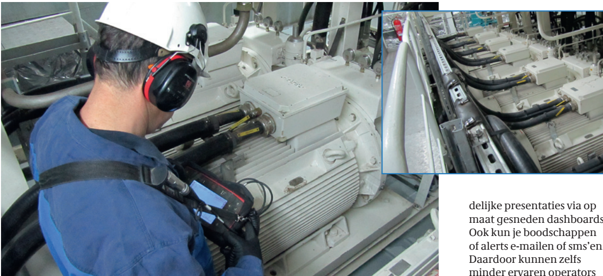
□ Trillingmetingen bij elektromotoren geven een indicatie van de lagerconditie.
